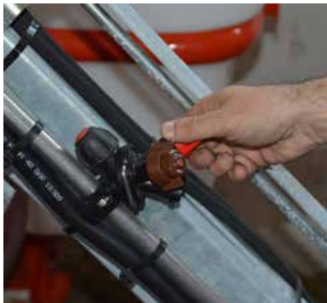
Smontaggio e pulizia degli ugelli con verifica dell'integrità delle guarnizioni
